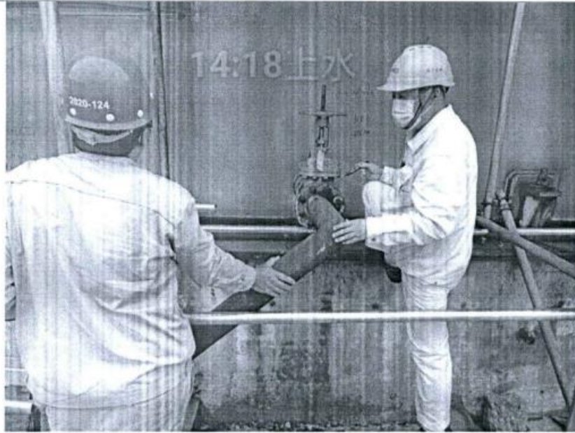
B 储罐开始充水试验
