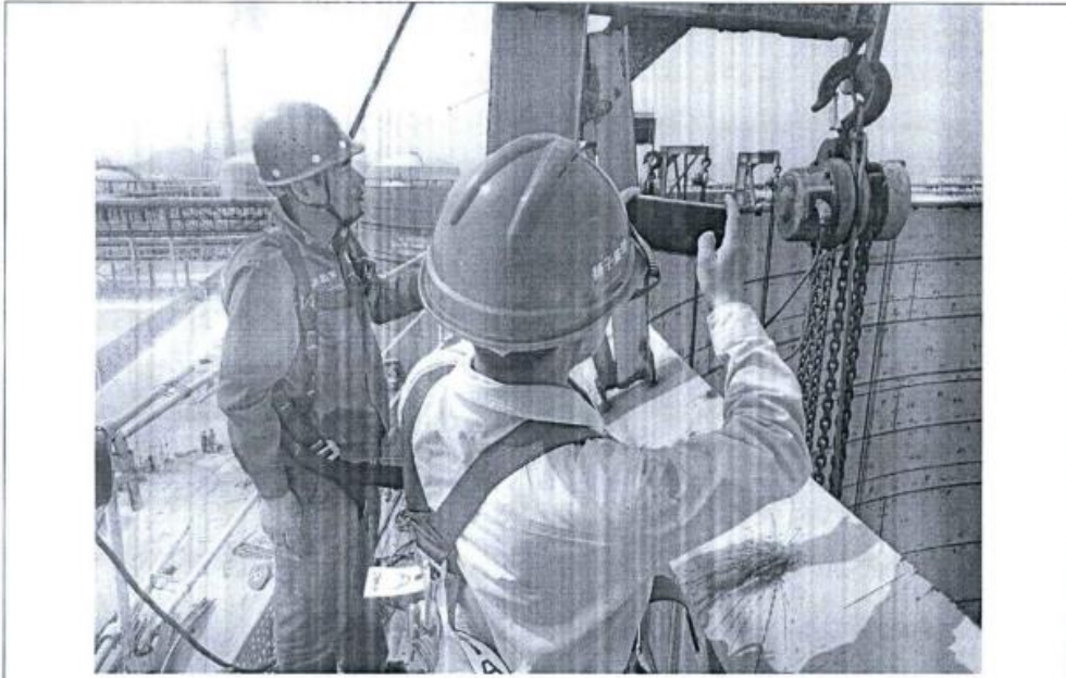
检查罐顶网壳提升系统
