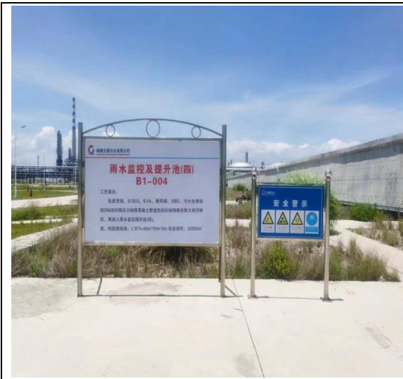
雨水监控池和事故水池
