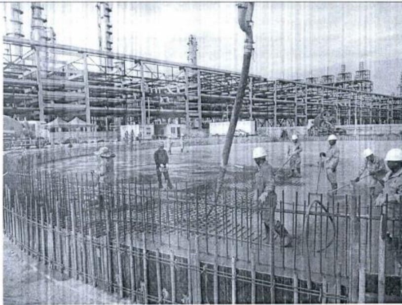
A 罐垫层施工完成
