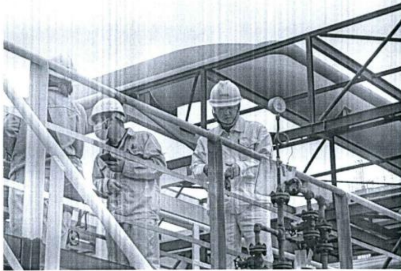
监理管道试压见证
