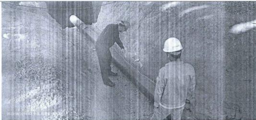
B 罐中粗砂回填施工
