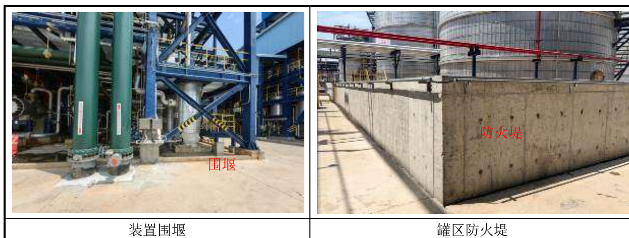
图 4.2-1 生产装置围堰或罐区防火堤现场照片
