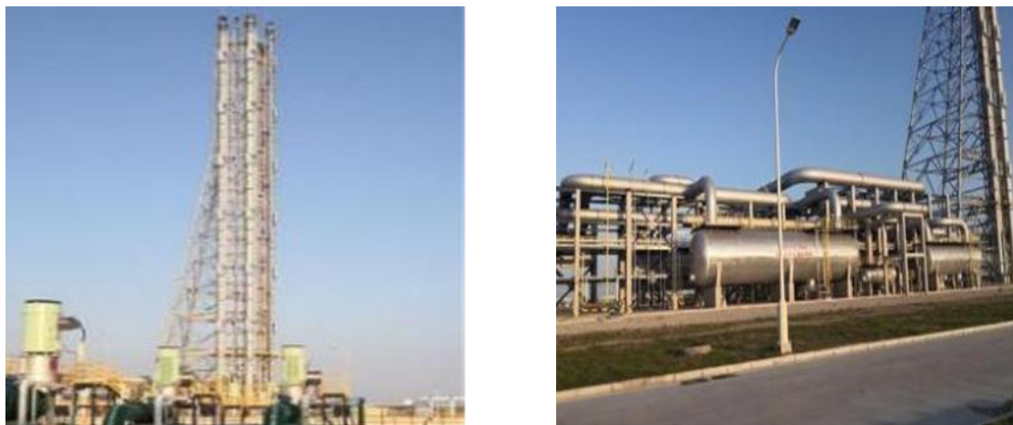
图 7.2-2 火炬系统现场图片
